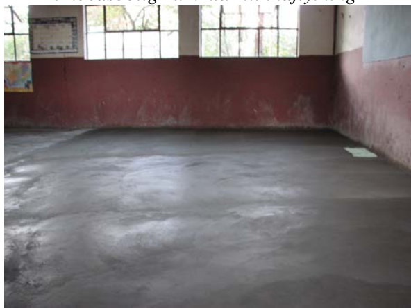
Og sådan ser det ud, efter at det er blevet repareret
